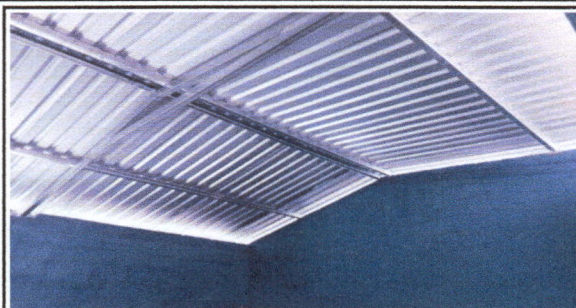
Foto 1: Cambio de entechado por costaneras, laminas troqueladas y columnas.
