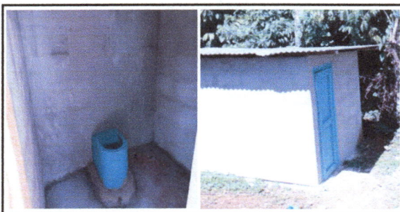
Foto 5: Sustitución de sanitarios escolares con paredes de block, estructura de metal y cubierta de lamina.
