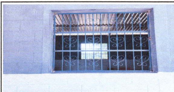
Foto 3: Cambio de las cuatro ventanas.
