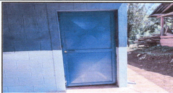
Foto 2: Cambio de puerta por una de metal.
